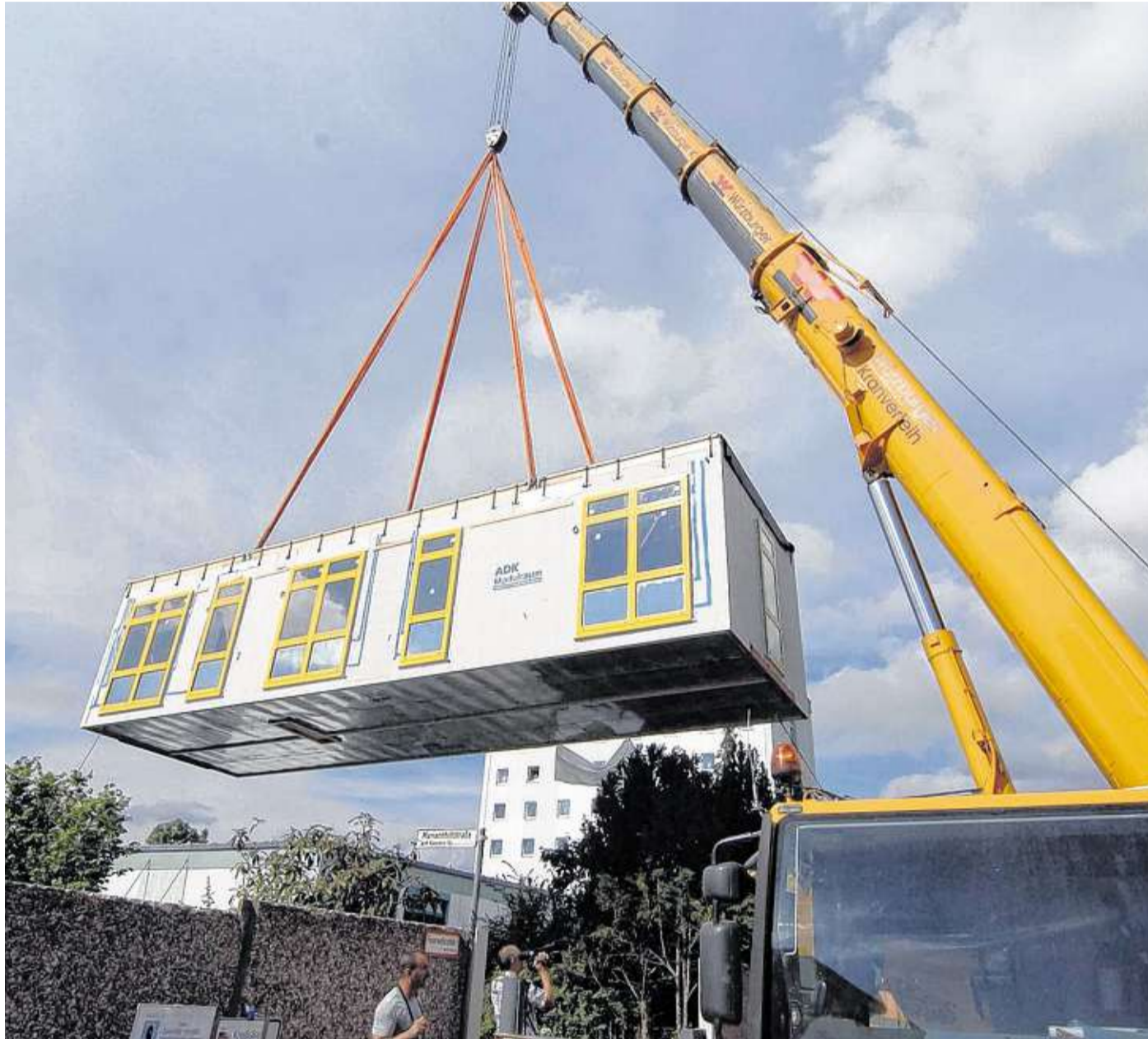
Schwere Last: Der Kran hievt den 49 Tonnen schweren Kreißsaal an der Missionsärztlichen Klinik durch die Luft.
